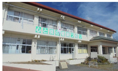
②びわ北小学校南校舎外壁等改修事業
