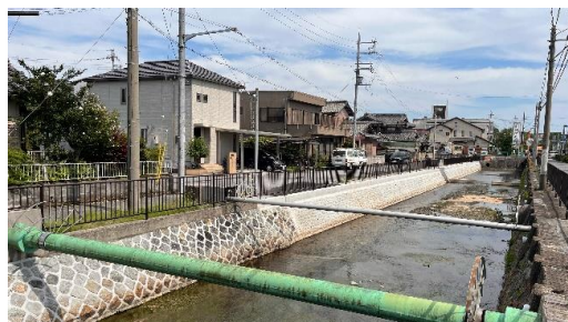
③準用河川大三六堀護岸改修事業
