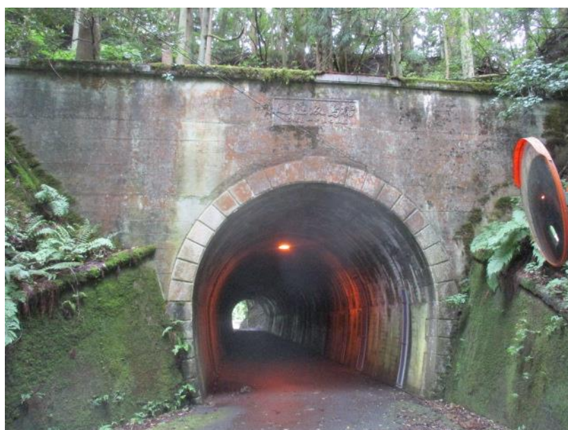
榑鳥坂隧道(昭和7年建設)
