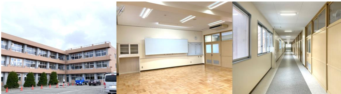
(令和5年度 浅井中学校施工実績)
