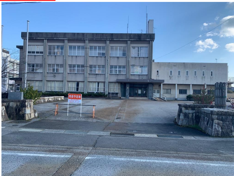
旧虎姫支所(北から) 主建物
