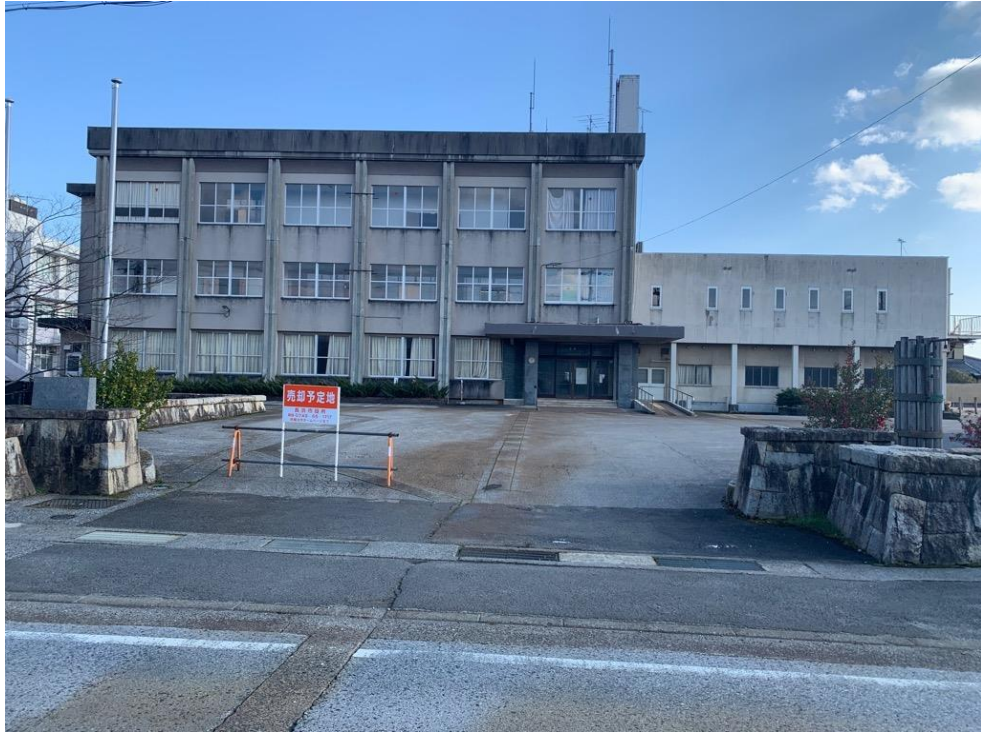
旧虎姫支所(北から) 主建物
