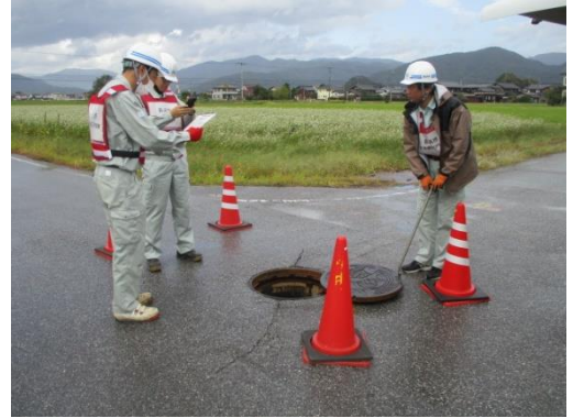
調査復旧班による管路施設点検
