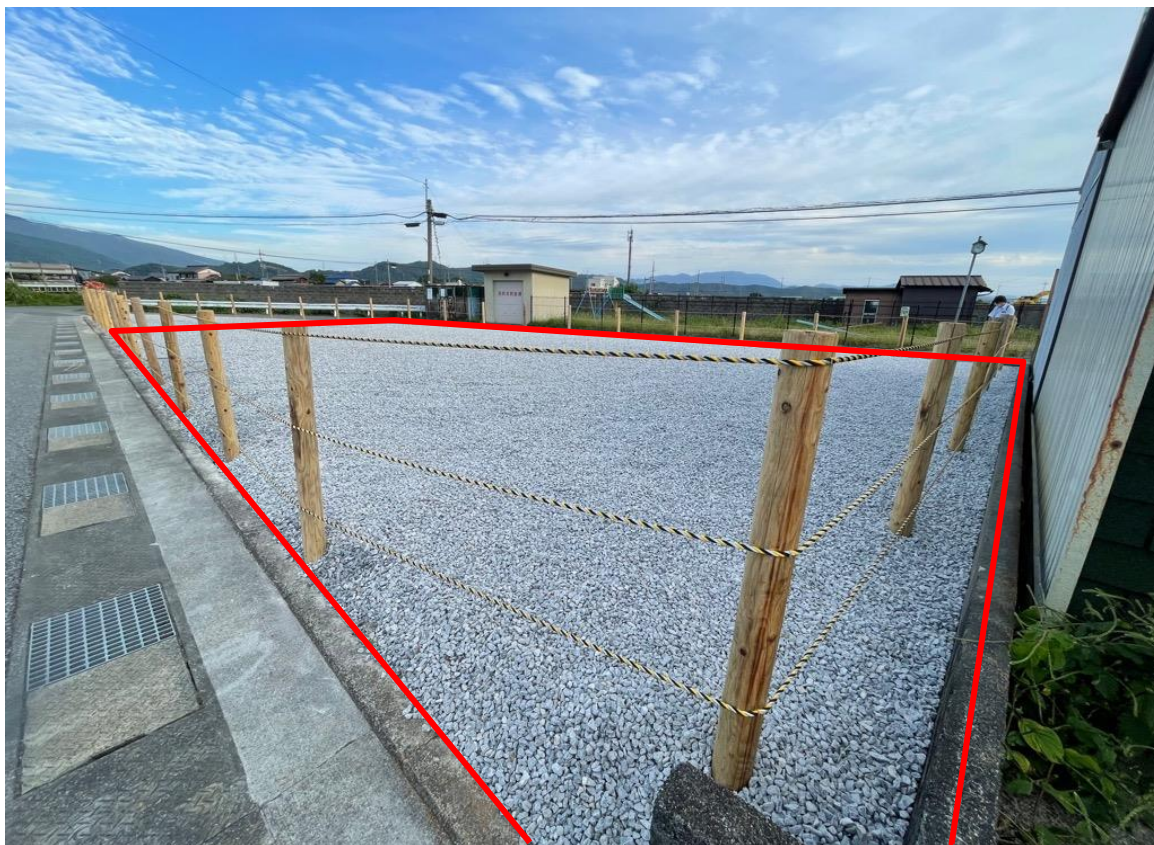
物件北西側から撮影
