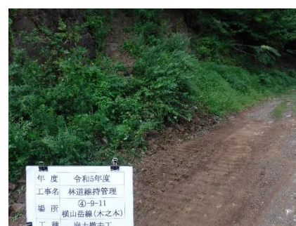
崩土（落石等）撤去完了
