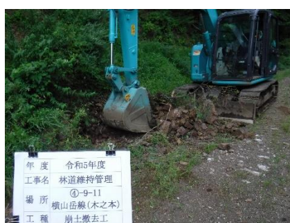
崩土（落石等）撤去作業
