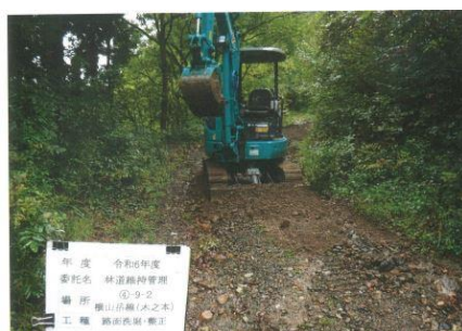
路面整正作業
