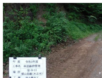
崩土（落石等）撤去完了
