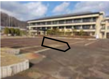
2台は正門から駐車場までの通路、 1台は駐車場に配車を予定。
