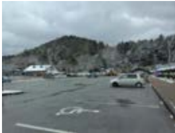
駐車場(敷地内すべて合わせて乗用車300台分)。
