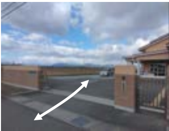
長浜南部学校給食センター駐車場。
