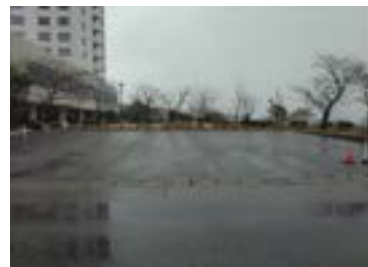
バス駐車場(大型駐車枠6台分)。
