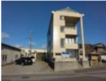
旅館正面。駐車場は乗用車6台。
