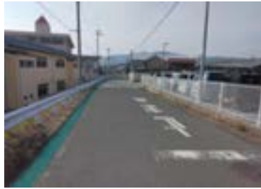
学校への進入路が狭い。
