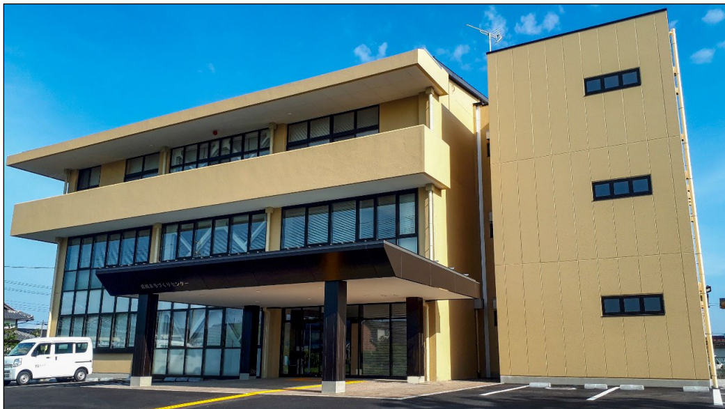
耐震改修した虎姫まちづくりセンター
