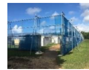
防風ネットの設置
