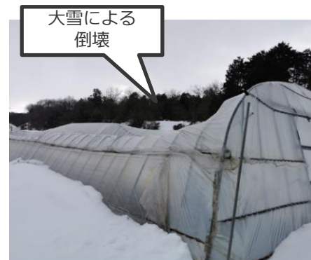
農業用ハウスの補強対策未実施
