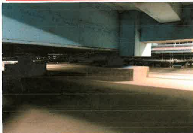
病院棟の建物：鉄筋コンクリート免震基礎構造
