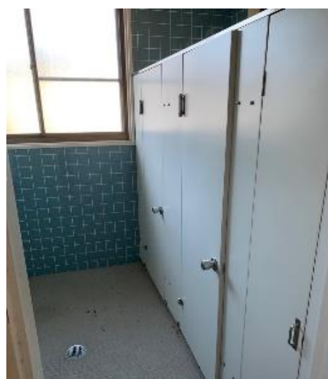
建物内部 便所(2)
