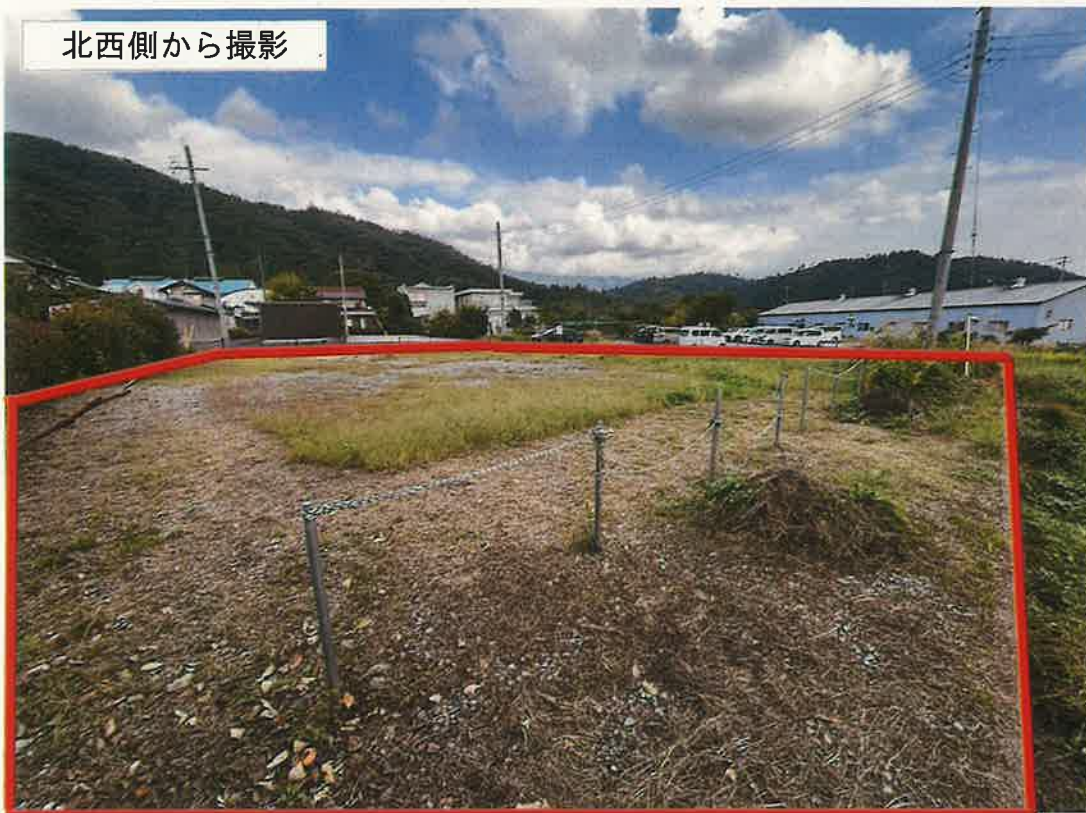
前面道路の状況
