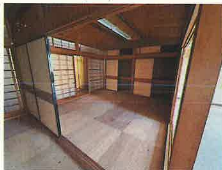
建物内部 南側和室
