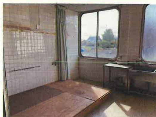
建物内観 給食室
