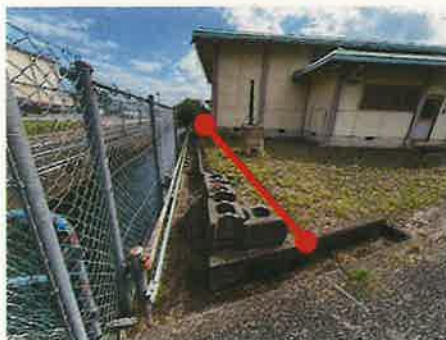
東側境界(北から)
