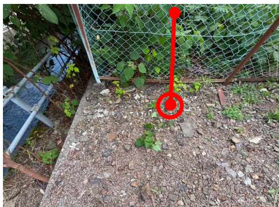
北東境界(北から)
