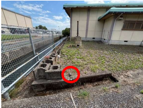
北東境界(北から)
