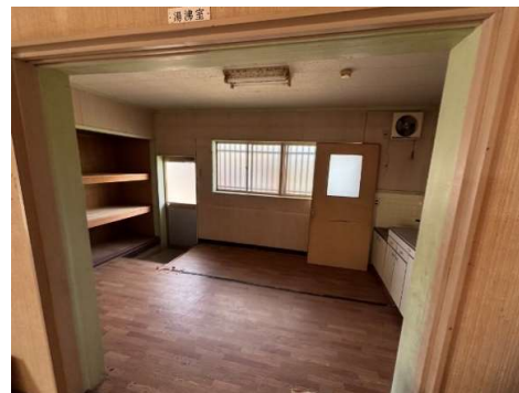
建物内部 湯沸室
