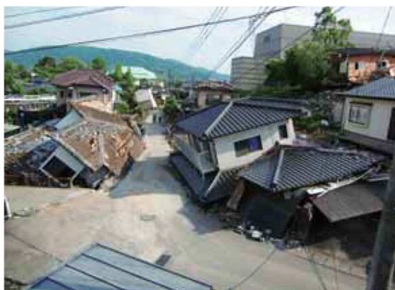
【写真】平成28年熊本地震により倒壊した家屋 出典：平成28年熊本地震における災害廃棄物処理の記録 （熊本県、平成31年3月）
