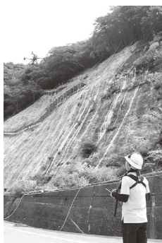
▲法面施工現場でのドローン活用
