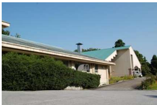
◆デイサービスセンター (リハビリデイサービス浅井) 機械浴槽2基
