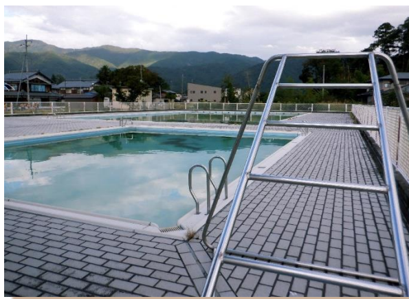
【 富永小学校 プール 】
