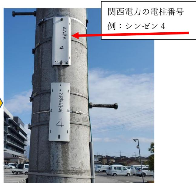
単独支柱の防犯灯は、近くの関西電力柱から電気を供給しています。写真では右側の関西電力柱から電気を引込んでいるのが分かります。引込み電線をたどり、引込んである関西電力柱の番号を教えてください。
