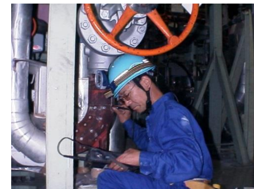
配管の厚み点検
