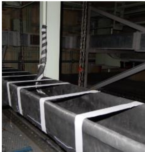
<防火シート施工箇所>
