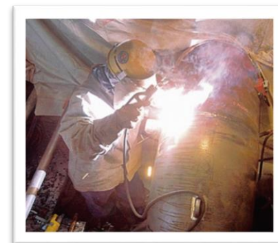
配管の取替え
