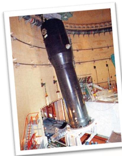
蒸気発生器の取替え
