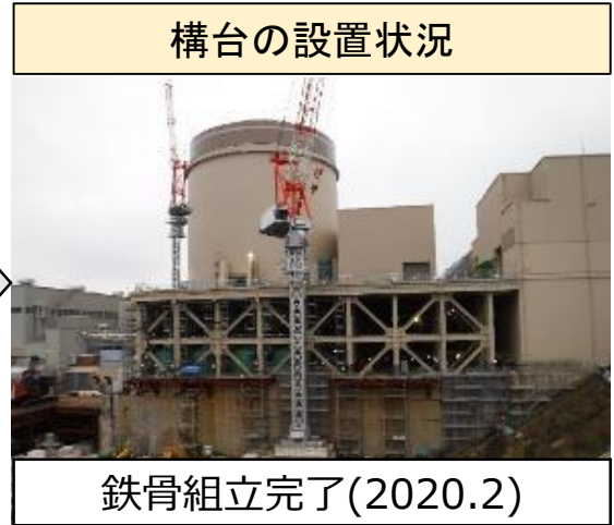
構台の設置完了後 炉内構造物取替工事へ引き渡し済み（2020.2.20）
