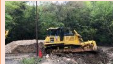
アクセスルート確保のための土砂撤去
