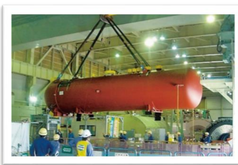
高圧給水加熱器の取替え
